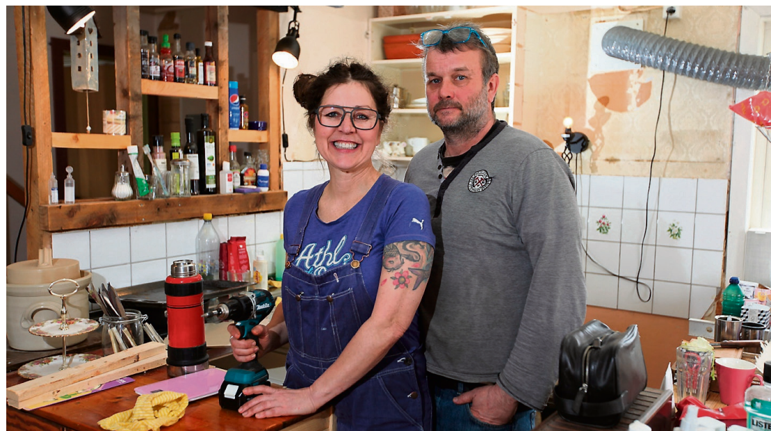
RENOVERER: Våningshuset ser ut som det det er, en byggeplass. – Vi renoverer alt innvendig, og skal ha overnatting i andreetasjen. Så skal vi bygge oss ei lita hytte der vi selv skal bo, sier ekteparet.
